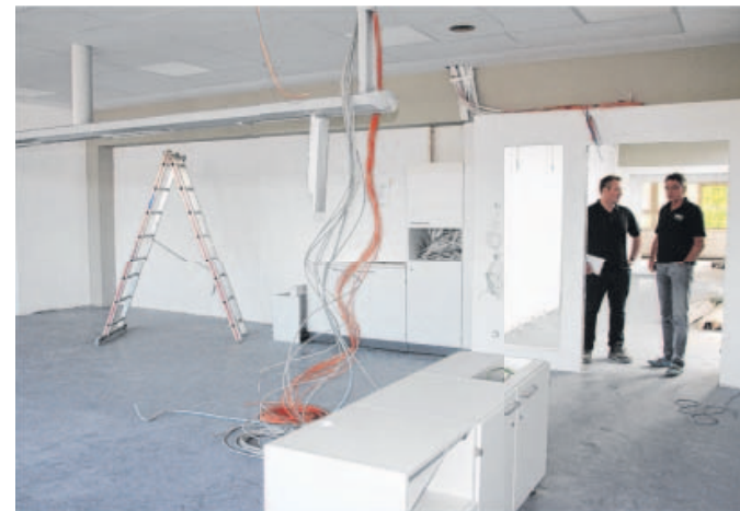
Architekt Bernd Ebert (links) und Konrektor Max Kopplin begutachten den Baufortschritt. In den naturwissenschaftlichen Fachräumen wird gerade die Technik installiert.
